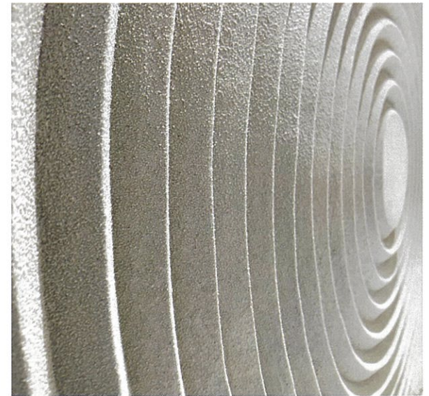
■ 峰仕上げ 漆喰を使用して凹凸模様を表現しています。
