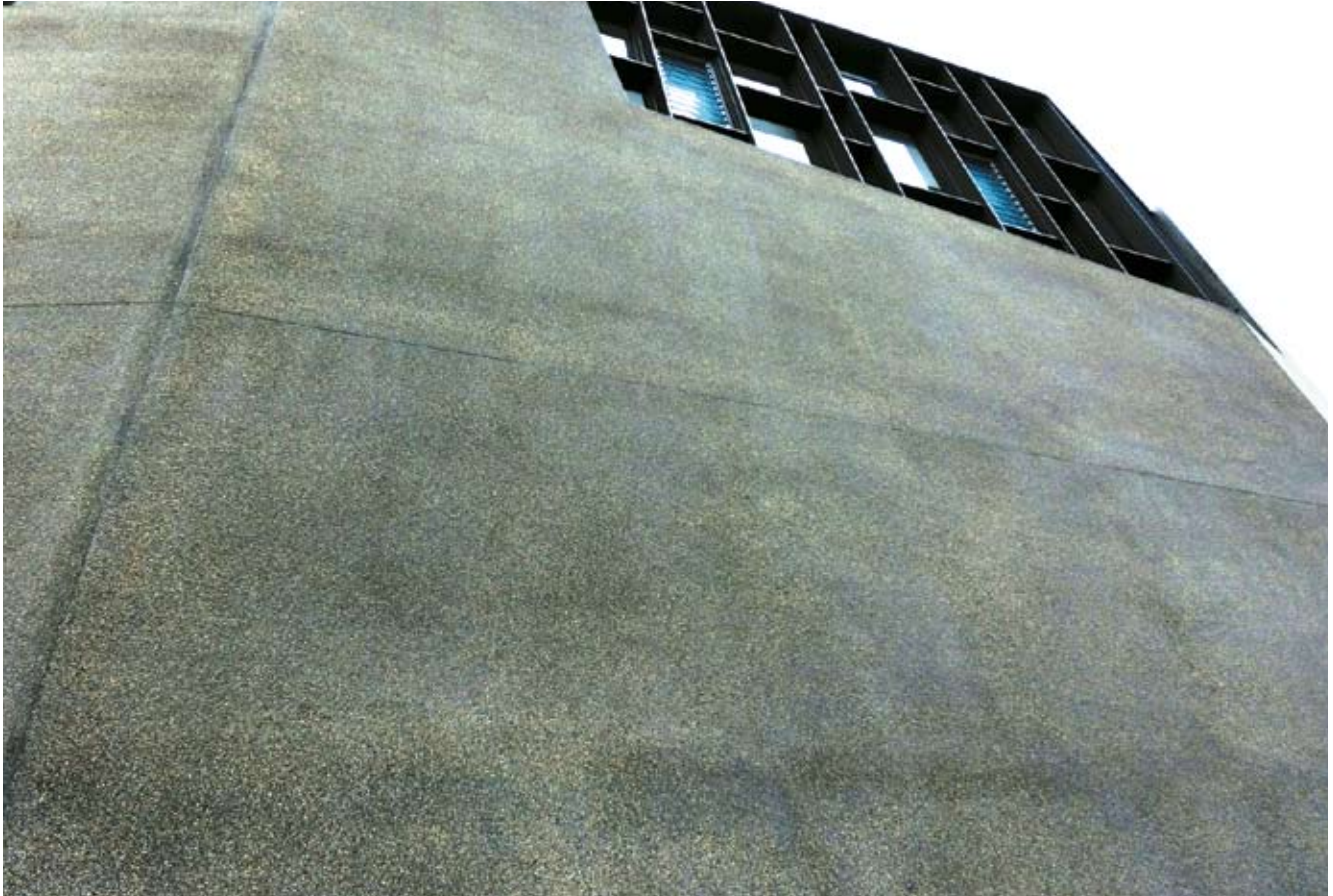
洗い出し【外壁】
